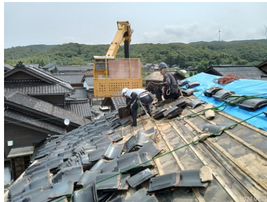
瓦の撤去作業状況
