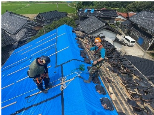
ブルーシート貼り付け作業状況
