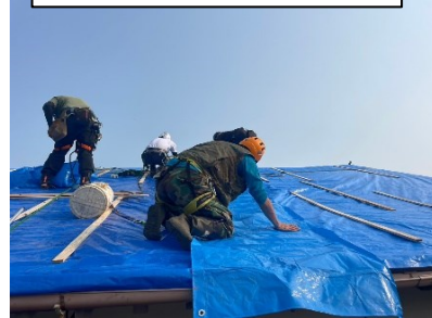
ブルーシート貼り付け作業状況
